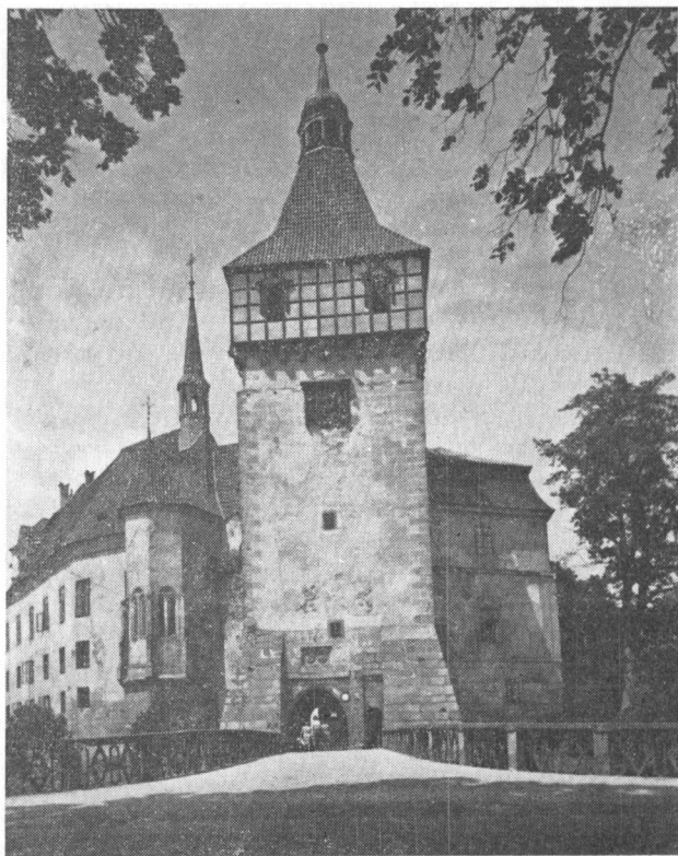
Obr. 1. Blatná hrad, okr. Strakonice. Celkový pohled na čelo hradu se vstupní věží. Foto K. Vlček.
