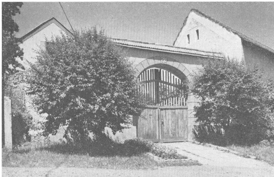
Obr. 34. Třebnice (PB) čp. 10. Nově upravená brána s pozdně gotickým ostěním. Stav 1975.
