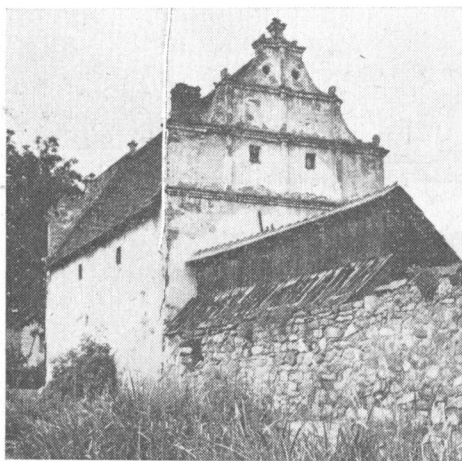
Obr. 28. Solopysky (PB) čp. 22. Celkový pohled na zděnou patrovou sýpku s renesančními štíty. Stav 1971.
