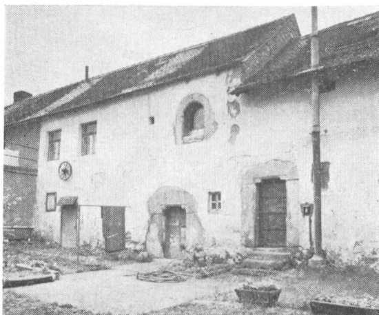
Obr. 17. Dublovice (PB) čp. 15. Celkový pohled na pozdně gotickou zadní část domu se dvěma sedlovými portály v přízemí a nově odkrytým portálem v patře. Stav 1981.
