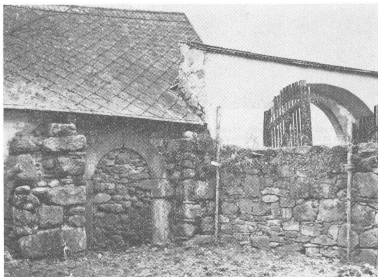
Obr. 10. Dražkov (PB) čp. 3 a 39. Rub brány s klenutým vjezdem a brankou, dodatečně rozdělené mezi dvě usedlosti. Stav 1973.
