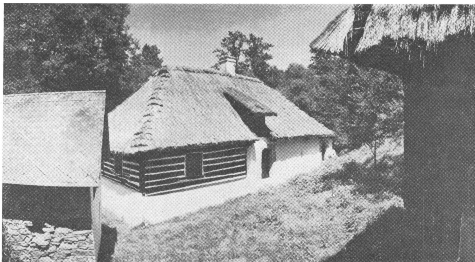
Obr. 1. Bláhova Lhota (okres Píbram) čp. 5 – mlýn. Celkový pohled na obytné stavení s pozdně gotickými porčály do síně a mlýnice. Stav 1975.
