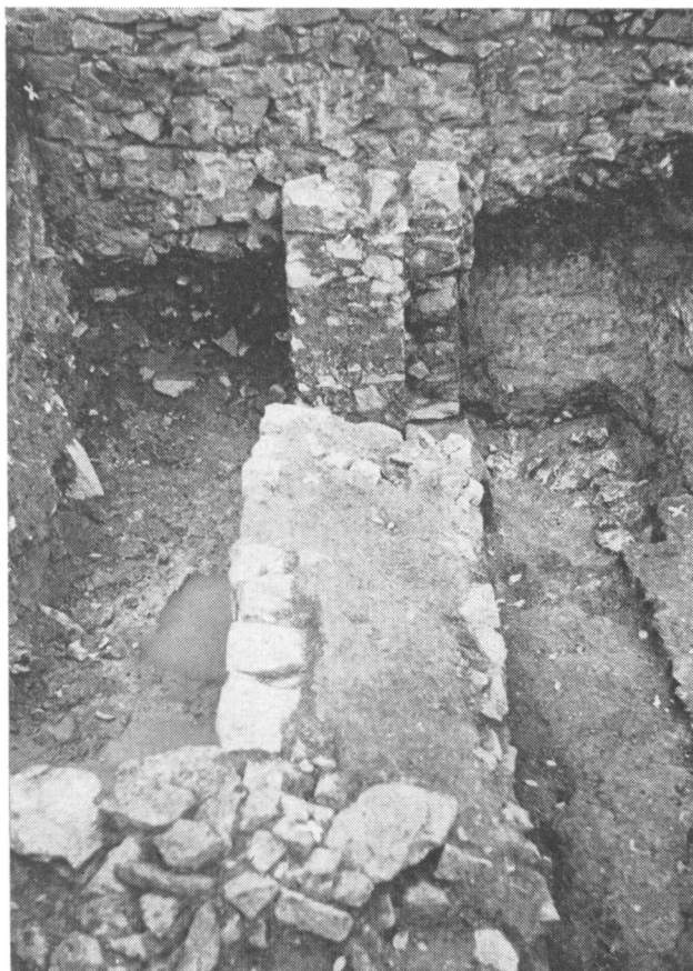
Obr. 8. Čimice (Praha 8). Základy kamenného domu. Foto: Fr. Čáp.
