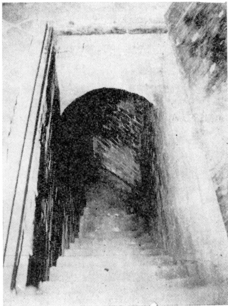
Obr. 5. Kurdějov, okr. Břeclav. Otevřený vstup do podzemních chodeb v kněžišti kostela. Foto: V. Prokop.
