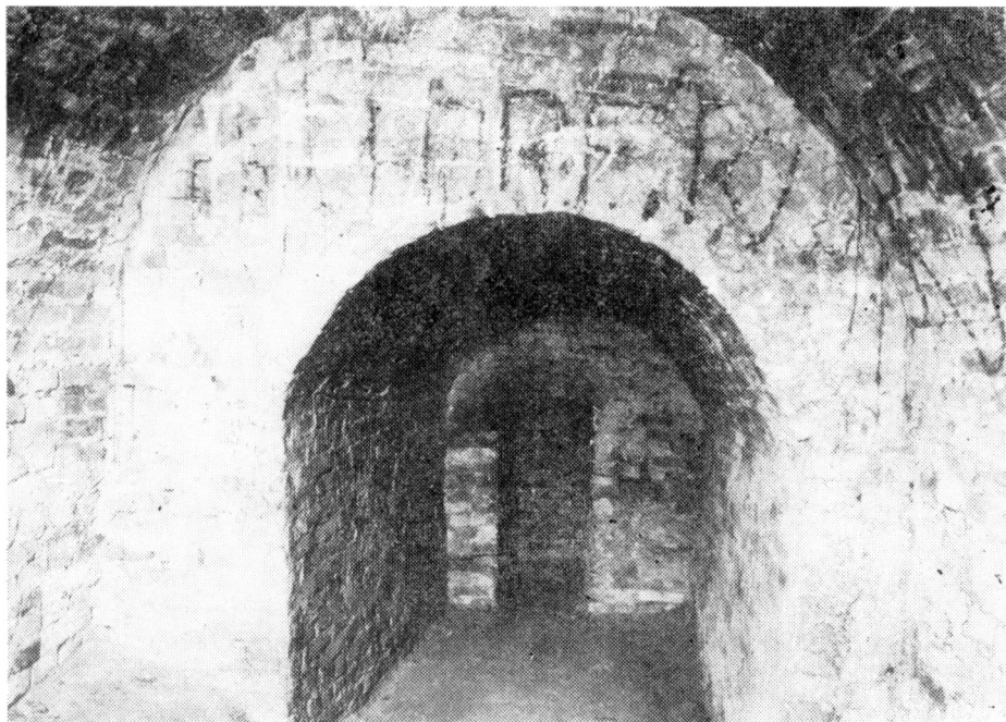
Obr. 6. Kurdějov, okr. Břeclav. První rozšířená prostora s nápisy a letopočty na stěnách. Foto: V. Prokop.
