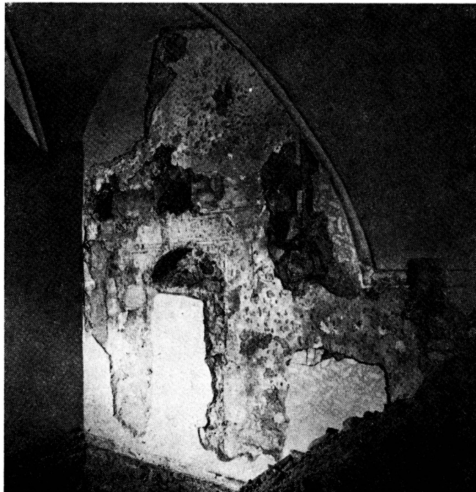
Obr. 6. Bratislava — Devín, kaštieľ na Hutníckej ul. č. 25. Pohľad na S interiérovú stenu najstaršieho objektu. Otvor (11) z III. etapy je rámovaný renesančnou maľovanou výzdobou s architektonickým motívom. Nad sa nachádzajú kapsy trámov schodiska.
