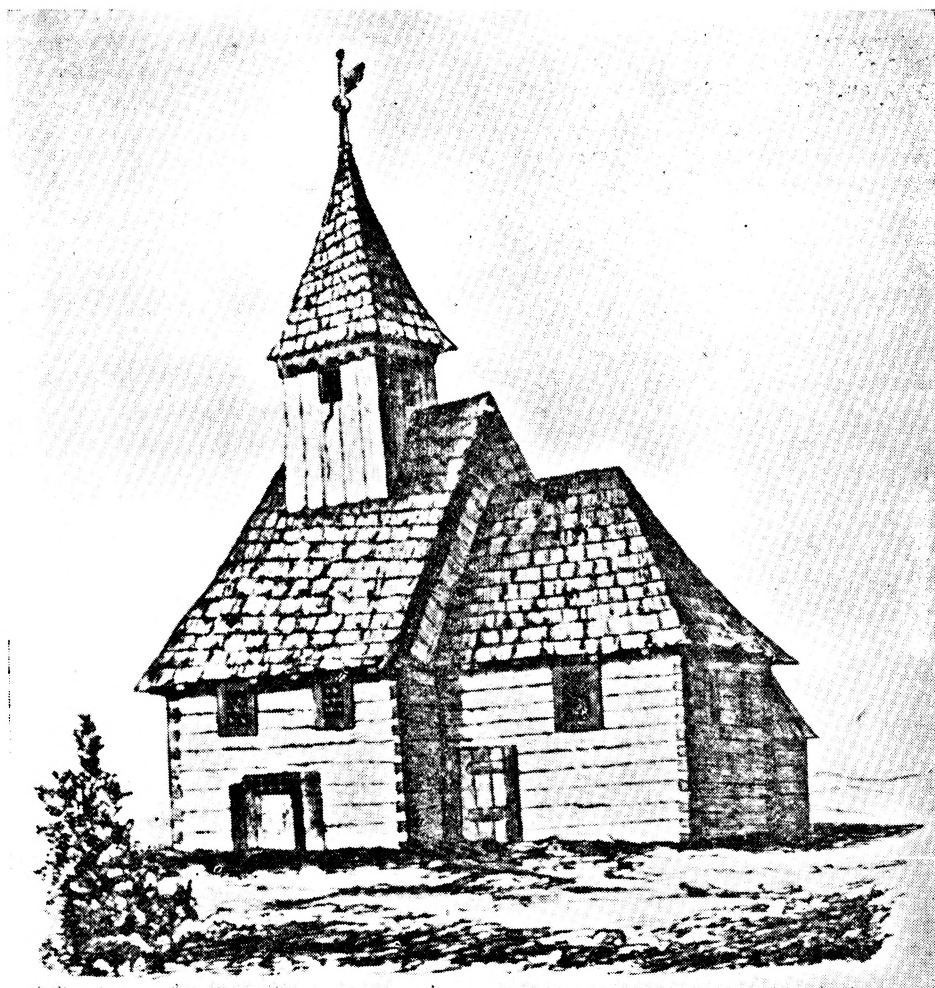
Obr. 6. Příklad dřevěné sakrální architektury jednoduchého půdorysného schématu s dobře patrnými prvky dispozice i detaily stavební technologie (roubená, v rozích přeplátovaná konstrukce stěn). Zaniklý kostel Nanebevzetí Panny Marie v Sádku u Opavy, 16. století, podle W. Merklase. Reprofoto J. Chlumská.
