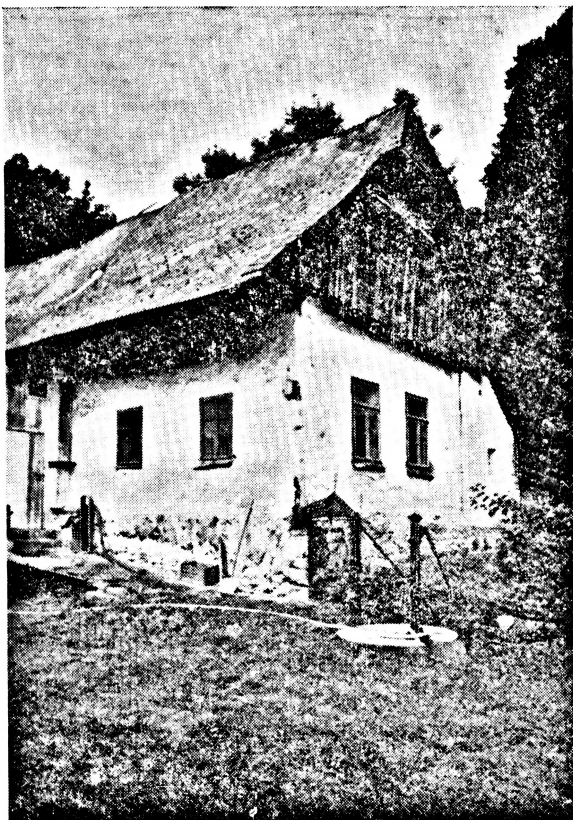
Obr. 3. Čistá čp. 171, dvortkové průčelí domu s novodobou verandou před vstupem a odřezanou pavlačí u zadní patrové části. Vlevo mladší kolmé hospodářské křídlo. Foto J. Škabrada, 1988.
