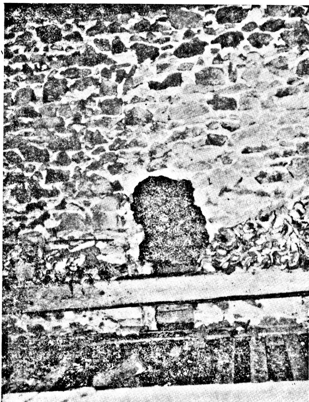
Obr. 3. Fragment ozvučnicové nádoby č. 1, osazené v cihlové kápi klenby. Foto J. Zavřel.
