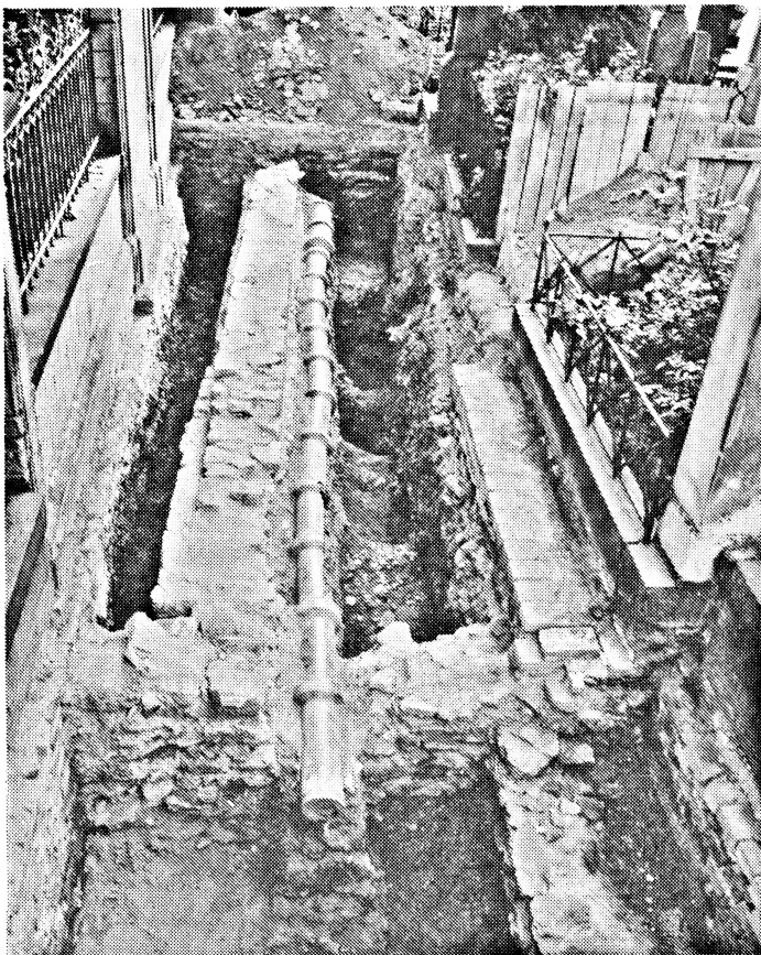
Obr. 2. Praha 2, Vyšehrad — sonda S—230, pohled od západu, v popředí starší zdivo, k němu připojeno zdivo mladší fáze, na pravé straně ve středu sondy dvě odpadní jámy s nálezy keramiky a číši českého typu.
