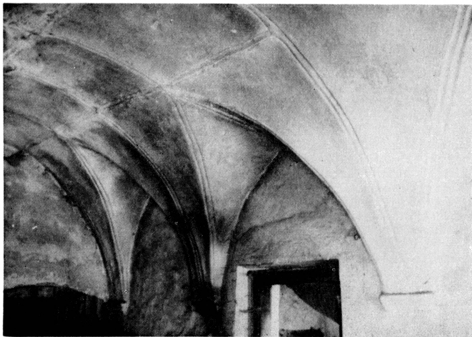
Obr. 13. Ůtěchov, o. Svitavy — klenba renesanční vstupní síně bývalého panského domu.
