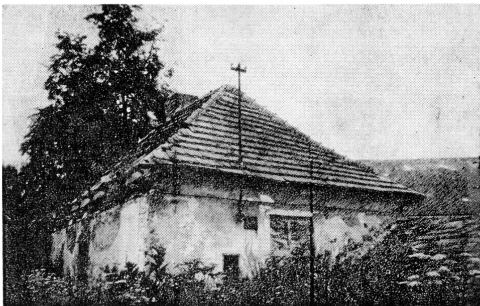
Obr. 15. Vrhaveč, domek v místech bývalé gotické věže, pohled od jihovýchodu. Stav roku 1993 (foto J. Človec).
