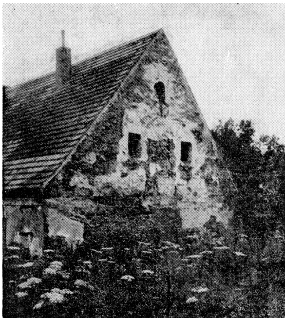
Obr. 13. Vrhavěč, východní průčelí renesanční tvrze, stav roku 1993 (foto J. Ůlovec).
