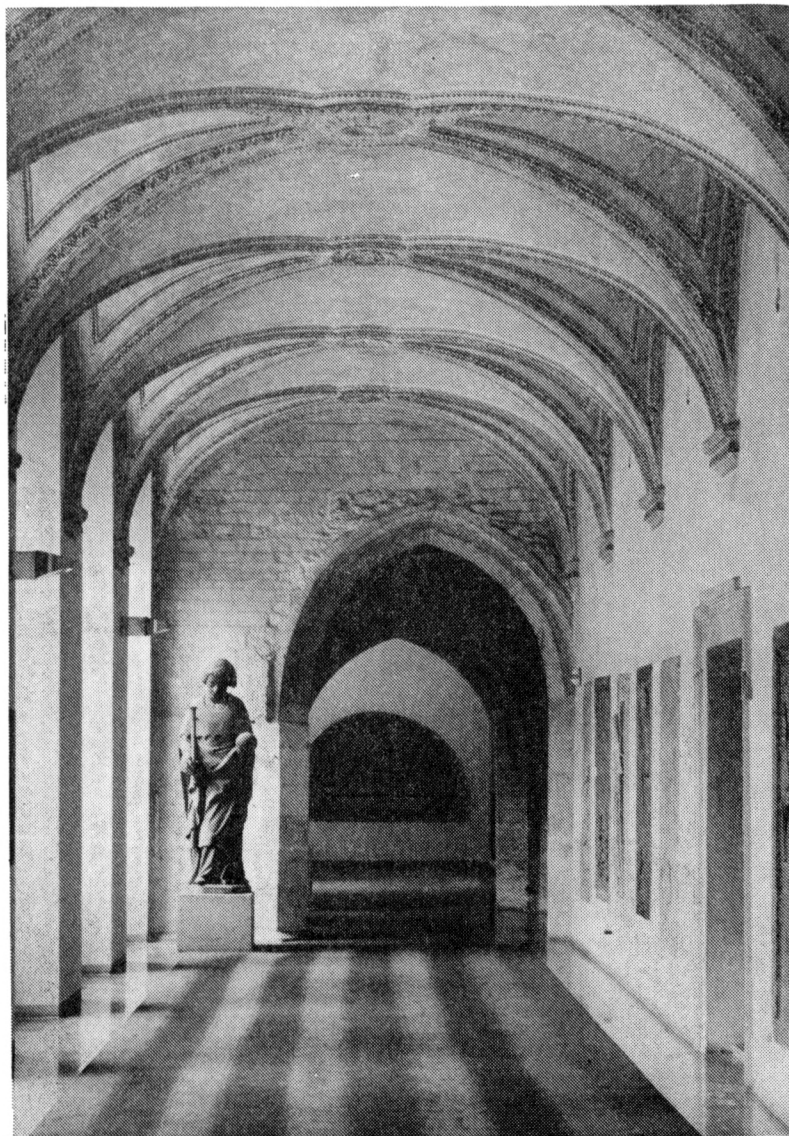
Obr. 3. Pražský hrad, klášter sv. Jiří. Dodatečné raně gotické oblouky v přízemí severní věže basiliky. Foto J. Koptiva.
