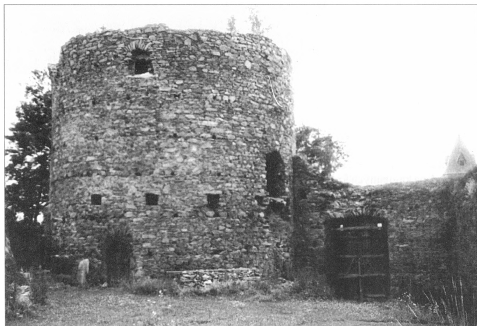
Obr. 10. Vimperk hrad, okr. Prachatice. Předsunutá bašta Haselburg, nádvoří strana bateriové věže s pozůstatky ochozu v patře a čelní zdi s bránou. Všechna foto T. Durdík.
