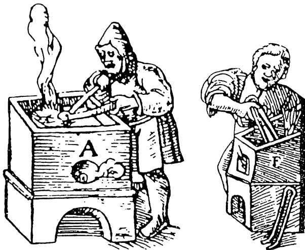
Obr. 12. Pece, jež nasávají vzduch průduchy (Agricola 1533, vlevo obr. s. 386: „Pec, do níž se nassává vzduch otvory A“, vpravo obr. s. 383).
