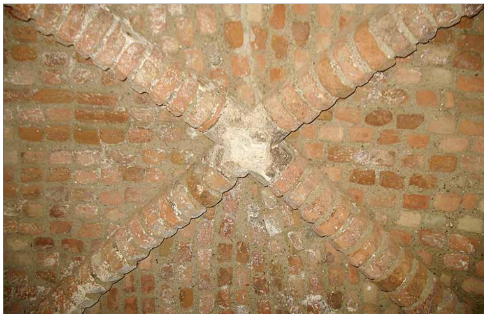
Obr. 15. Klenba s rebrami z okosených tehlových tvaroviek doložená na viacerých trnavských stavbách primárnej mestskej zástavby, ale aj na stavbách z neskoršieho gotického obdobia. Abb. 15. Gewölbe mit Rippen aus Formziegeln mit gebrochenen Kanten, in mehreren Bauten der primären Stadtbebauung Trnavas, aber auch in spätgotischen Bauten belegt.
