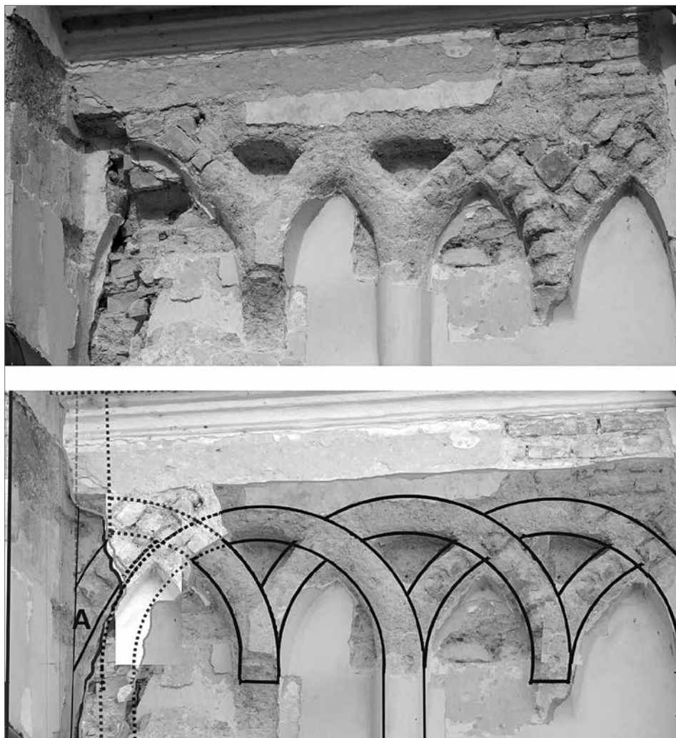
Obr. 16. Príklad uplatnenia románskeho slohového aparátu (obkročný vlys), vyhotoveného z moderných tehál – prstoviek, fasáda apsidy, kostol v Jelke, 3. štvrtina 13. storočia. Hore detail vlysu s pôvodnou povrchovou úpravou (maltou rozmazanou po povrchu muriva) po čiastočnom odkrytí sondážou; dole rekonštrukcia pôvodného stavu oblúčkového vlysu pri napojení apsidy na pôvodnú loď.
