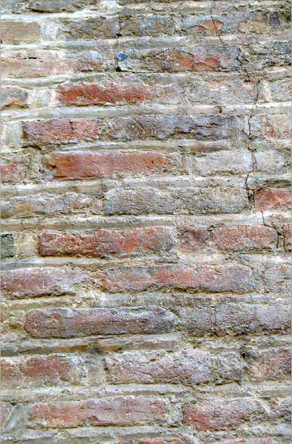
Obr. 9. Typ škárovania s maltou vyprofilovanou do trojuholníka, meštiansky dom v Trnave, Hlavná 5, začiatok 14. storočia (?). Abb. 9. Verfugungstyp mit keilförmig profiliertem Mörtel, Bürgerhaus in Trnava. Hlavná-Str. 5, Anfang 14. Jahrhundert (?).
