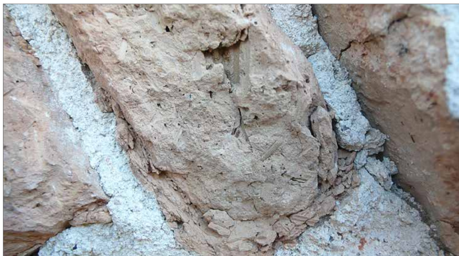
Obr. 18. Prierez plefovou tehľou so stopami po vypálených plevách a odrezkoch slamy, kostol v Hrnčiarovciach nad Parnou, 1. polovica 13. storočia.
