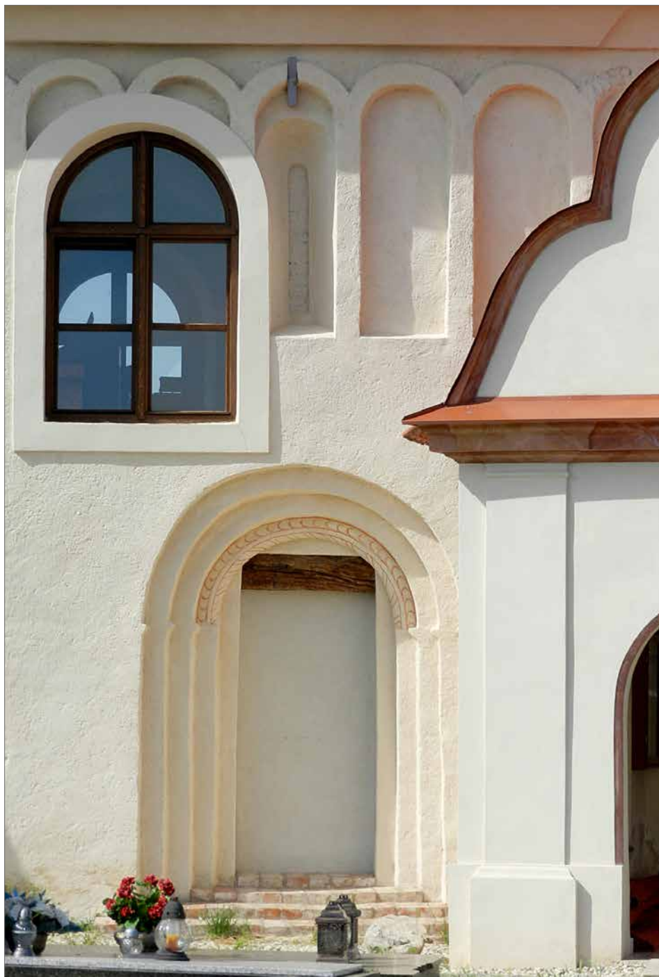
Obr. 12. Bohatý slohový výraz stavby z plefových tehál s fasádou členenou slepými arkádami a viacstupňovým portálom na kostole v Šaštíne-Strážach, 1. polovica 13. storočia. Foto M. Kalinová.
