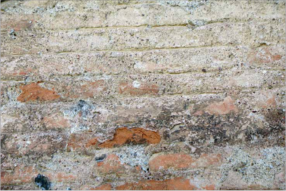
Obr. 6. Mladší typ trnavského škárovania s vrysovaním ložných škár do čerstvej malty, meštiansky dom v Trnave, Štefánikova 32, 20. roky 14. storočia.
