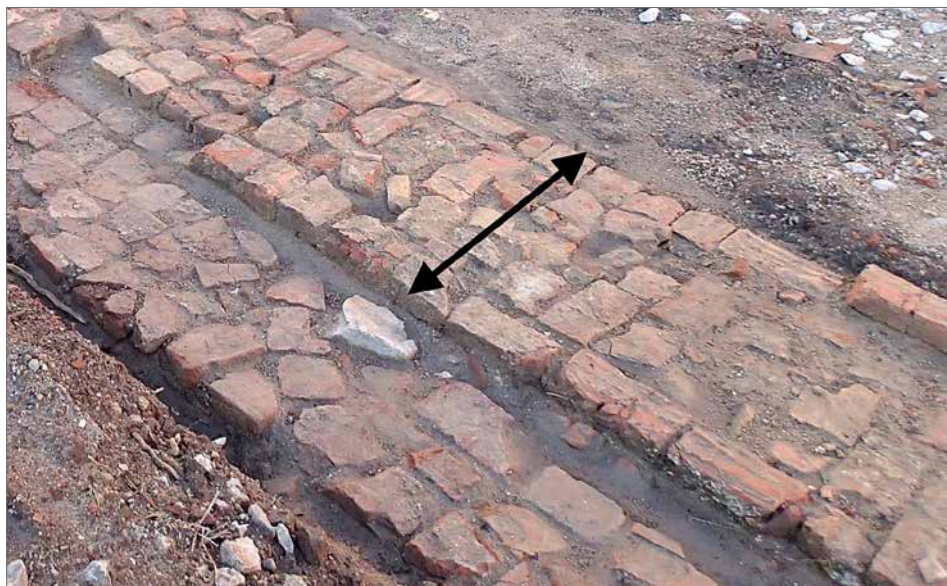
Obr. 10. Dvojitá šípka označuje korunu typického základu, vymurovaného spôsobom dvojplášťovej konštrukcie s nehomogénnym jadrom, parcela v Trnave na Halenárskej ul., južne od Štefaneu.
