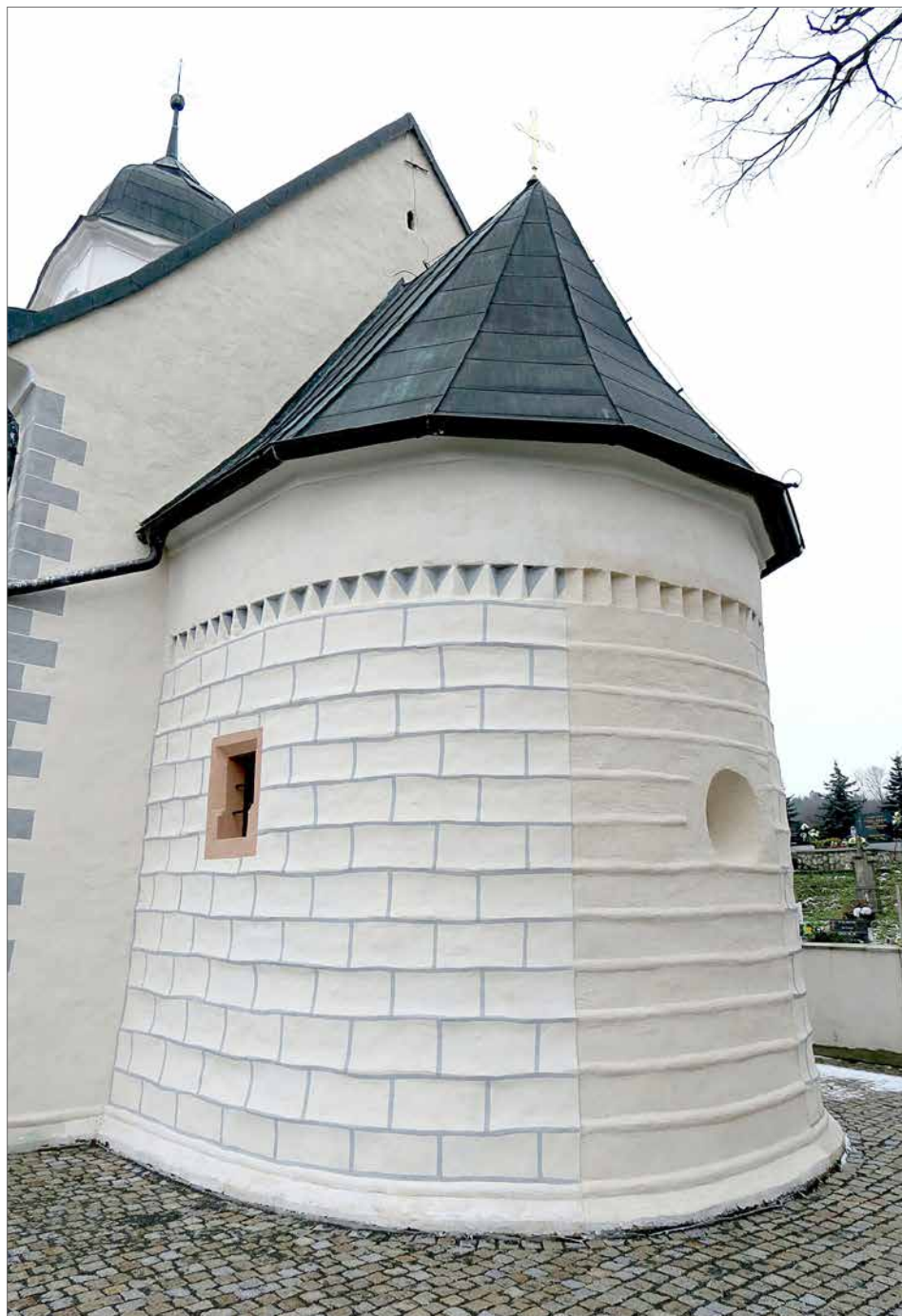
Obr. 28. Apsida Kostola Všetkých svätých v Dechticiach po obnove, formou analytickej sondy je prezentované románske horizontálne členenie fasády predstúpenými riadkami tehál. Zvyšok apsidy bol obnovený v gotickom výraze.
