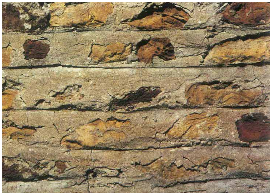
Obr. 5. Typ škárovania s vyrysovaním ložných škár do čerstvej malty, kostol z niekdajšieho benediktínskeho opátstva, Pomposa, Taliansko, 9./10. storočie. Podľa Meyer 1993, 26.
