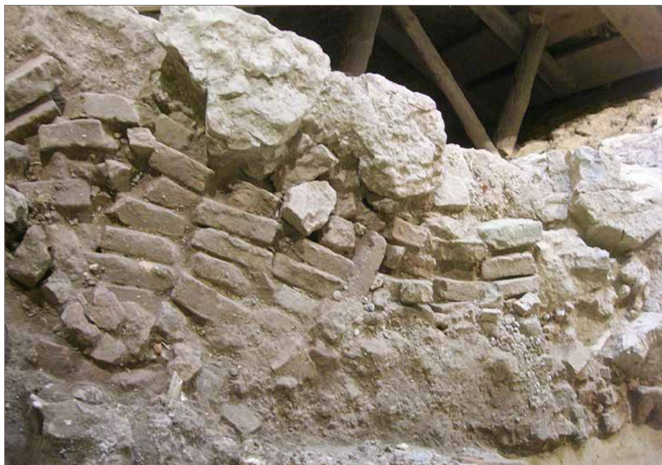
Obr. 19. Odkrytá koruna trnavského karnera s kamenným interiérovým lícom a jadrom z pravdepodobne sekundárne použitých plevových tehál (v niektorých riadkoch kombinovaných s lomovým murivom), 2. polovica 13. storočia.
