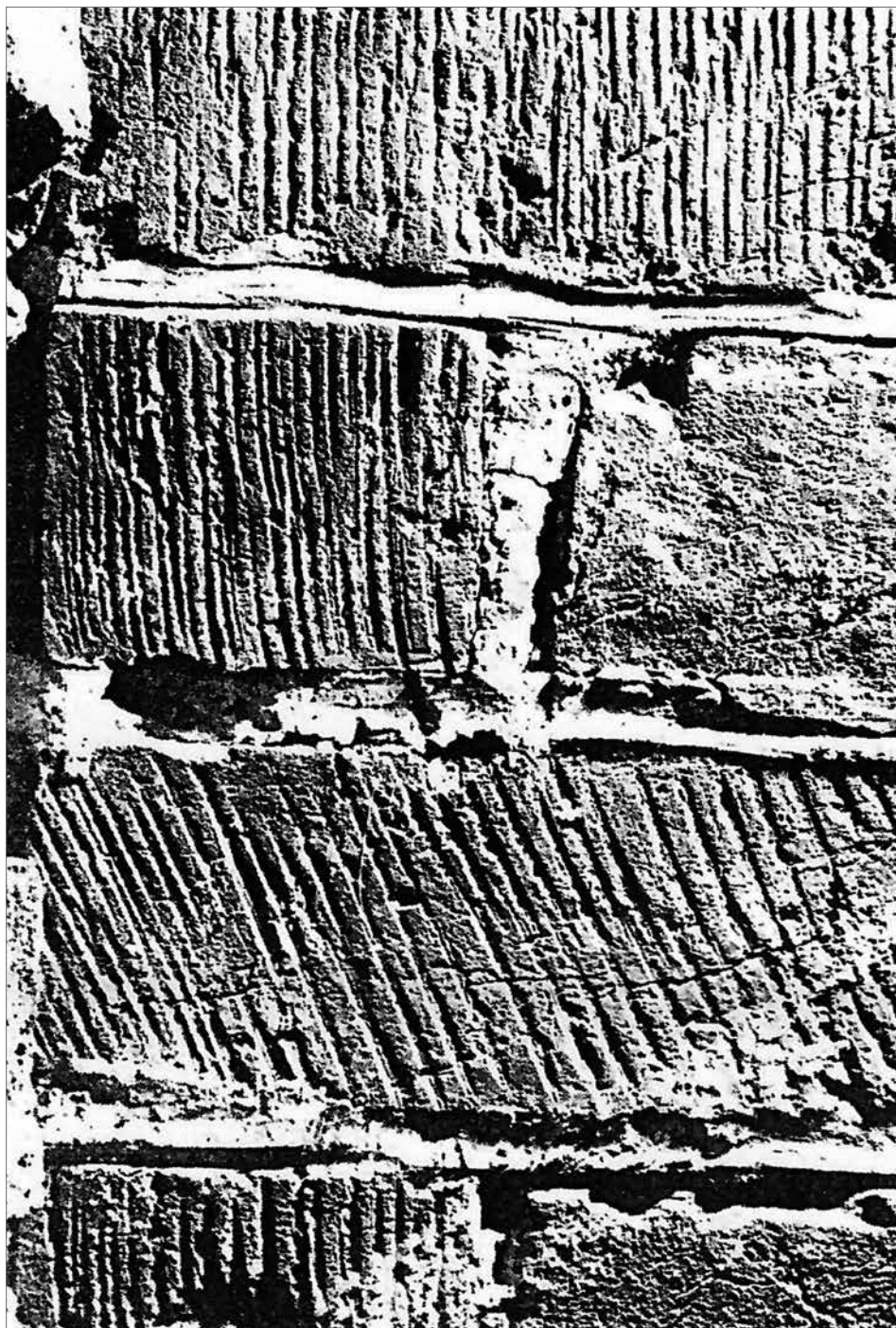
Obr. 8. Typ škárovania s maltou vyprofilovanou do trojuholníka, dedinský kostol v Lubow, kraj Mecklenburg, koniec 12. storočia. Podľa Zahn 1984, 55.
