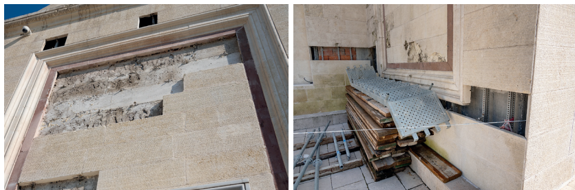
Obr. 5 a 6. Obklady vnějších stěn Sinánovy mešity z prefabrikovaného umělého kamene.
