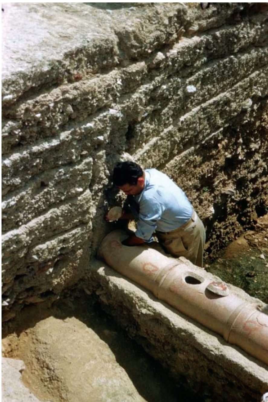
Obr. 4. Názorná ukážka čistenia potrubia Peisistratovho akvaduktu na aténskej Agore. Zdroj: http://www.romanaqueducts.info/aquasite/athens1/foto32.html
