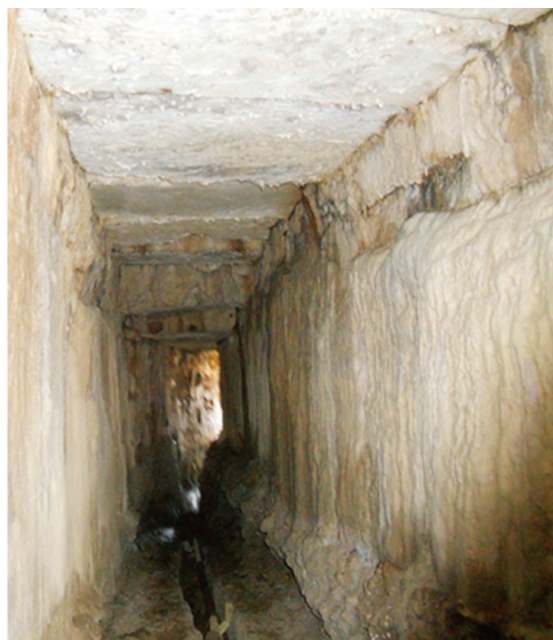
Obr. 17. Tunel akvaduktu č. 2 v Polyrrhenii. Zdroj: Voudouris a kol. 2013
