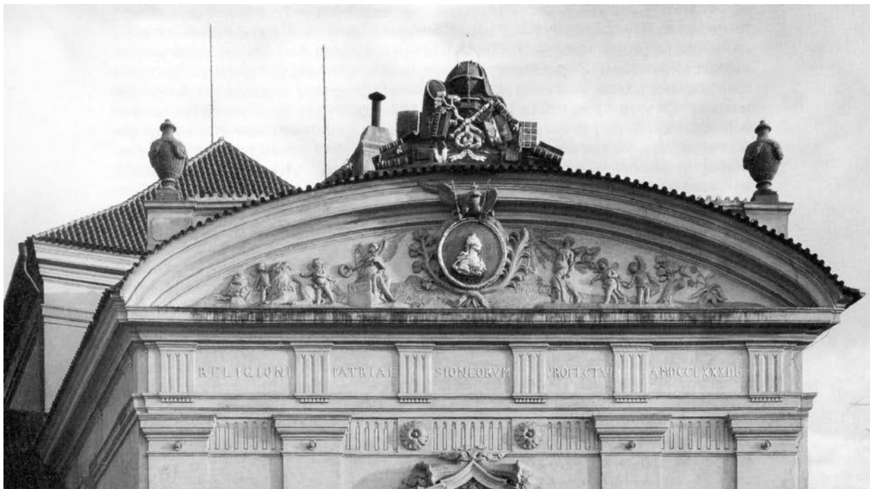
4 – Ignác František Platzer, Sochařská výzdoba průčelí knihovní budovy s tzv. Filosofickým sálem , 1783. Praha, klášter premonstrátů na Strahově
