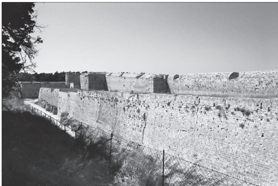
Obr. 14. Obezďný val (terreplein) v příkopu mezi branou Koskinou a Anglickou baštou.
