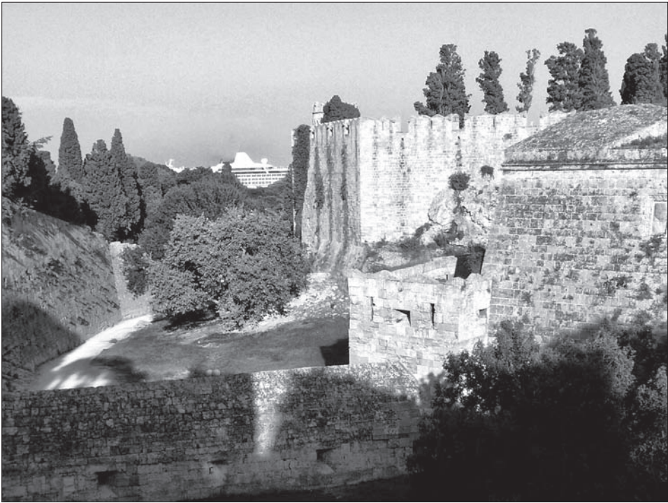
Obr. 8. Opevnění severozápadního nároží města a hradu s kaponierou (batardeau) v příkopu. Abb. 8. Befestigung der nordwestlichen Stadtecke und der Burg mit Kaponniere (Batardeau) im Graben.
