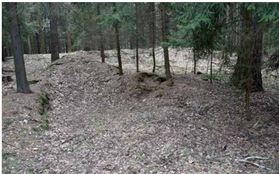
Obr. 4. Dachovské Paseky – Majlant, k. ú. Dachov, okr. Chrudim. Obj. 25 – okop pro tank ve věžovém postavení. Vpravo je patrný výklenek po propadlém pohotovostním krytu. Pohled od východu. Foto J. Musil.
