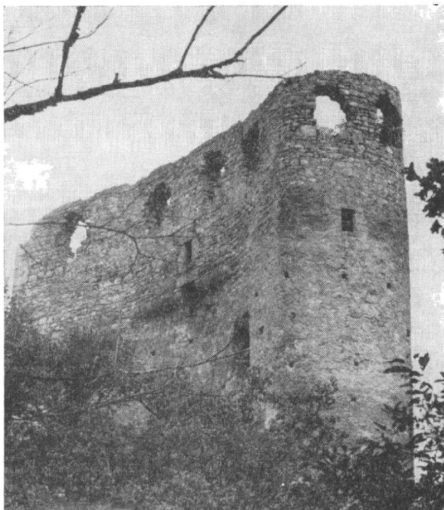
Obr. 9. Valečov. Pohled na palác od Jihovýchodu.
