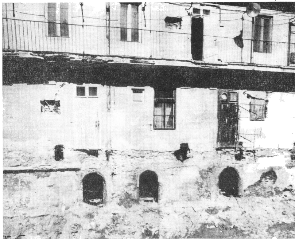
Obr. 3. Košice – MPR – Hlavná 58. Gotické portály v suterénu budovy.
