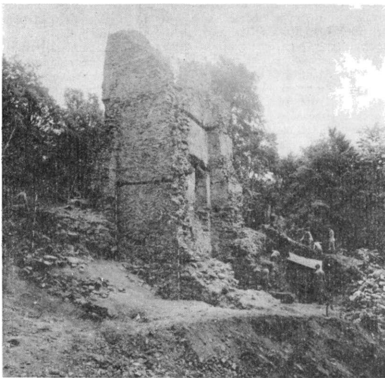
Obr. 1. Pohľad od juhozápadu na skúmaný objekt vstupnej veže. Foto: V. Hanullak.
