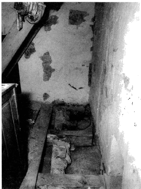
Obr. 9. 1. poschodie veže s barokovým domurovaním čelnej strany portálového výstupku medzi trámami záklopového stropu, nad pôvodnou vodorovnou plošinou.
