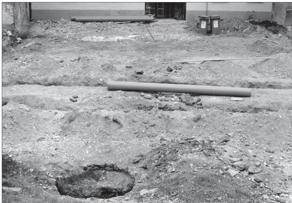
Obr. 5. Cheb, blok C3. Jímka 1/2001.
