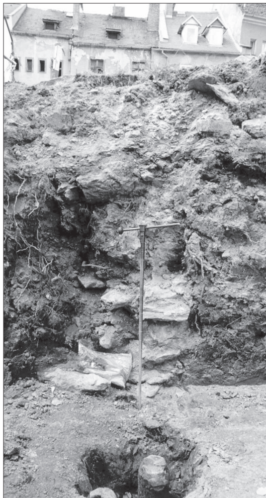
Obr. 7. Cheb, blok A2. Piloty pod základy kamenných zdí. Abb. 7. Eger, Block A2. Stützpfähle unter den Fundamenten der Steinmauern.
