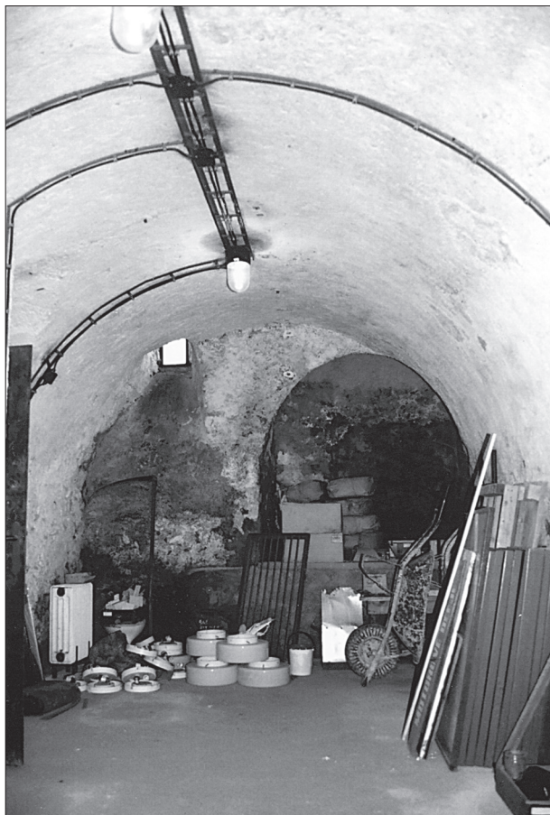
Obr. 7. Jeseník, zámek, severní raně novověký sklep pod východním křídlem, pohled k západu se zaslepeným vstupem z nádvoří, stav v roce 2006. Foto Dalibor Prix.
