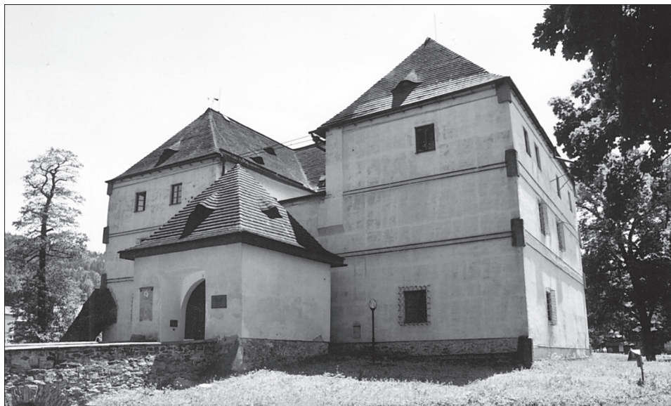
Obr. 1. Jeseník, zámek, celkový pohled od severozápadu, stav v roce 2006. Foto Dalibor Prix. Abb. 1. Jeseník, Schloß, Gesamtansicht aus Nordwesten, Zustand im Jahr 2006. Foto Dalibor Prix.
