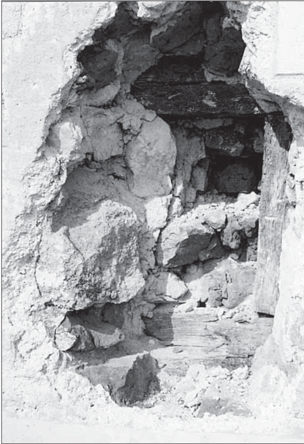
Obr. 3. Odkrytá strieľňa s dubovou výstužou na 1. nadzemnom podlaží kúrie. Exteriér. Foto Z. Ševčíková.
