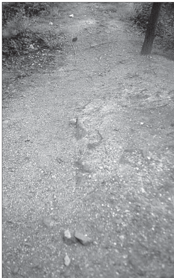
Obr. 8. Karlík, hrad, k. ú. Mořina, okr. Beroun. Reliéfní reliktní nádvorní stěny čelní stavby s vystupujícími kameny jejího vnitřního líce. Stav v roce 2003. Foto autor.
