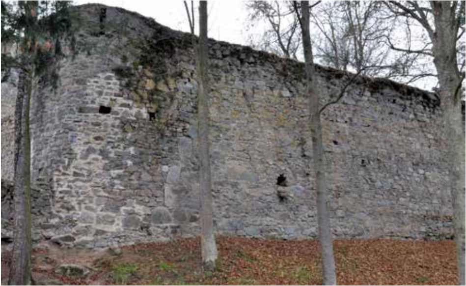
Obr. 13. Hrad Zvíkov, okres Písek. Nárožní bašta a přiléhající úsek severní hradby. Foto J. Varhaník, 2011. Abb. 13. Burg Klingenberg, Bezirk Písek. Eckbastion und daran anschließender Abschnitt der nördlichen Wehrmauer. Foto J. Varhaník, 2011.
