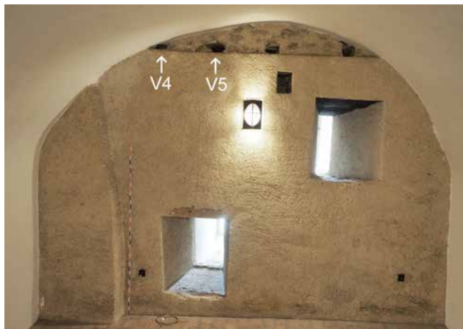
Obr. 5. Trenčiansky hrad. Južná stena 3. NP veže s vyznačením vzoriek stavebných drev. Foto M. Bóna. Abb. 5. Burg Trenčín. Südwand 3. OG des Turms mit Kennzeichnung der Bauholzproben. Foto M. Bóna.
