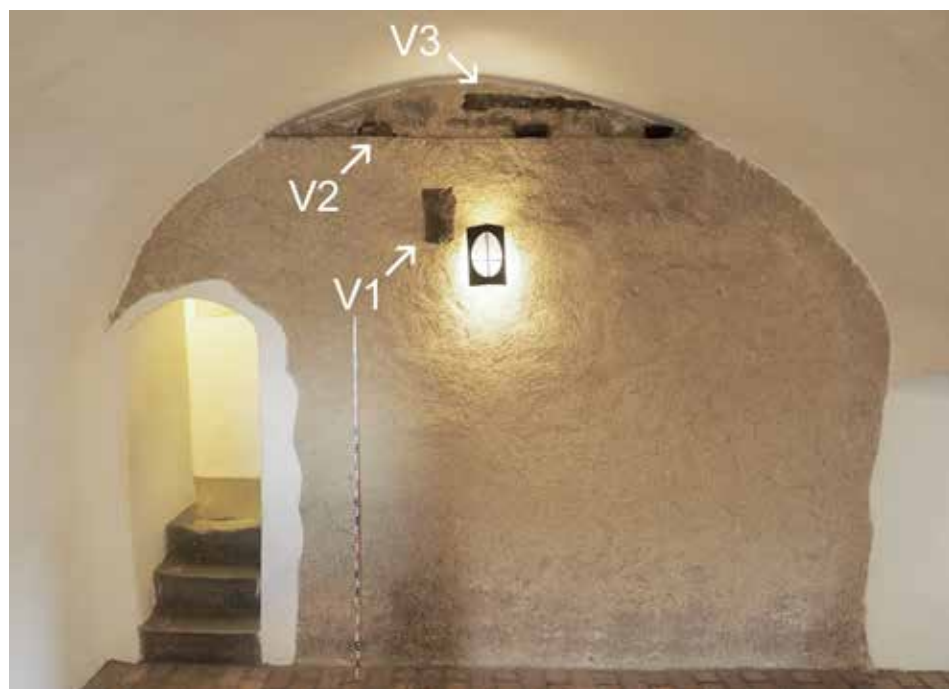
Obr. 4. Trenčiansky hrad. Severná stena 3. NP veže s vyznačením vzoriek stavebných drev. Foto M. Bóna. Abb. 4. Burg Trenčín. Nordwand 3. OG des Turms mit Kennzeichnung der Bauholzproben. Foto M. Bóna.
