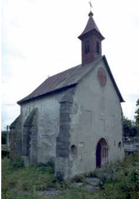
Obr. 12. Veľký Šariš, Kaplnka sv. Kunhuty, pohľad zo severozápadu. Foto Archív Pamiatkového úradu SR, Zbierka fotografií, sign. 206172.
