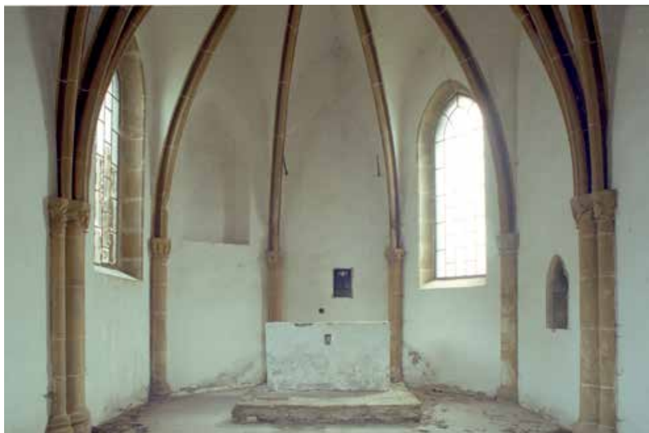
Obr. 13. Veľký Šariš, Kaplnka sv. Kunhuty, interiér, pohľad k východu. Foto Archív Pamiatkového úradu SR, Zbierka fotografií, sign. 206163.
