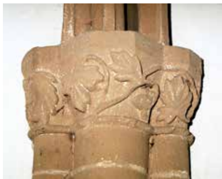
Obr. 14. Veľký Šariš, Kaplnka sv. Kunhuty, detail hlavice na zväzkovej klenbovej prípoje bočnej steny. Foto Archív Pamiatkového úradu SR, Zbierka fotografií, sign. 206165.
