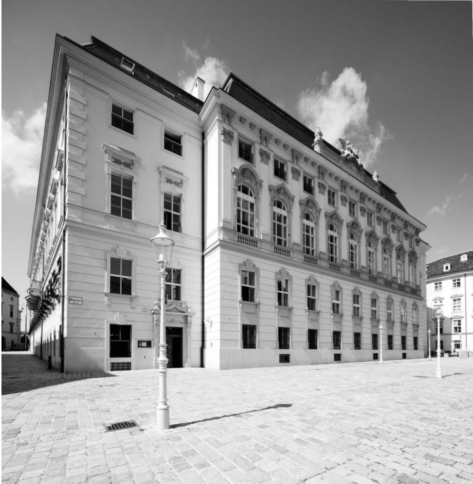
Abb. 1: Außenansicht des Haus-, Hof- und Staatsarchivs (Foto: HHStA).
