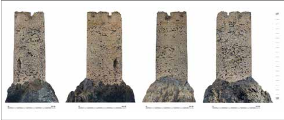
Obr. 9. Věž hradu Skalka – fotoplány. Zleva doprava pohledy od severu, východu, jihu a západu. Autor P. Hlavenka.
