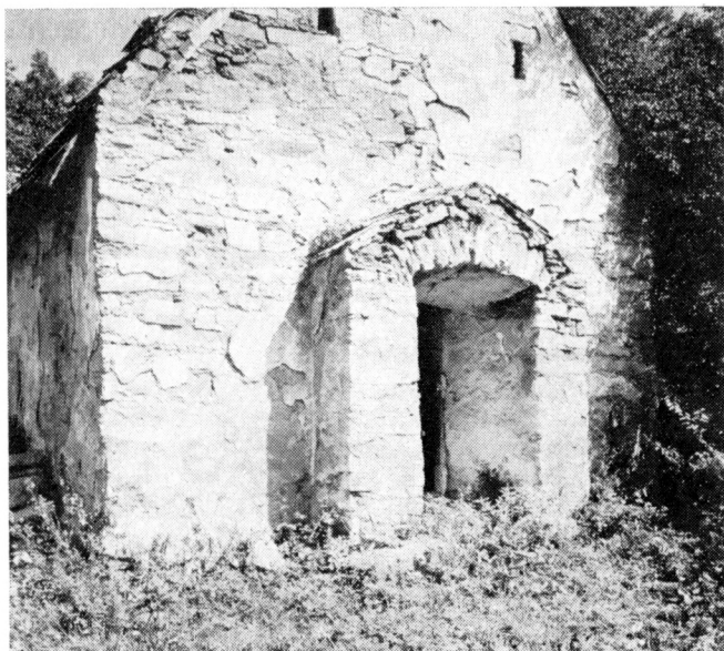
Obr. 11.–13. Ujezd u Chanovic (okres Klatovy), sýpka v usedlosti čp. 12 — půdorys, podélný řez, pohled na šíji. Samostatná kamenná sýpka s trámové zastropeným přízemím a horním podlažím s lepenčem, neseným hambalkovou konstrukcí. Vstup ve štitové stěně je opatřen mohutnou šíjí s nikou v levé vstupní stěně, se sedlovou stříškou. Sýpka byla pravděpodobně postavena kolem roku 1800 nebo v 1. pol. 19. století. Kresba Z. Němcová, foto autor.
