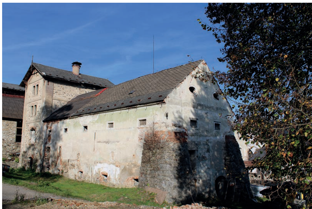
Obr. 2: V jádru středověká budova někdejšího pivovaru ve Vyšším Brodu (foto autorka).
